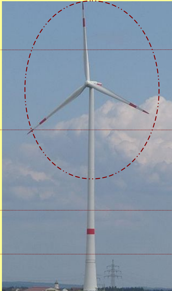
éolienne de 2 à 3 MW V110-2 nacelle à 125 m, pales de 55 m
