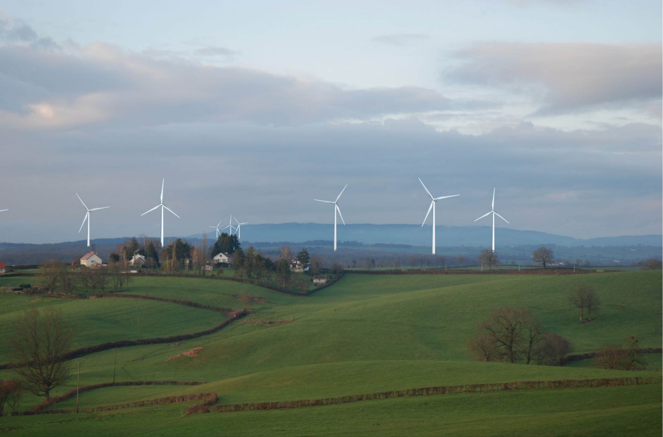
Sanvignes – espace libre rue de Toulon : Vue partielle du parc Sud (1ère éolienne à 3100 m) et parc Nord dans le lointain
