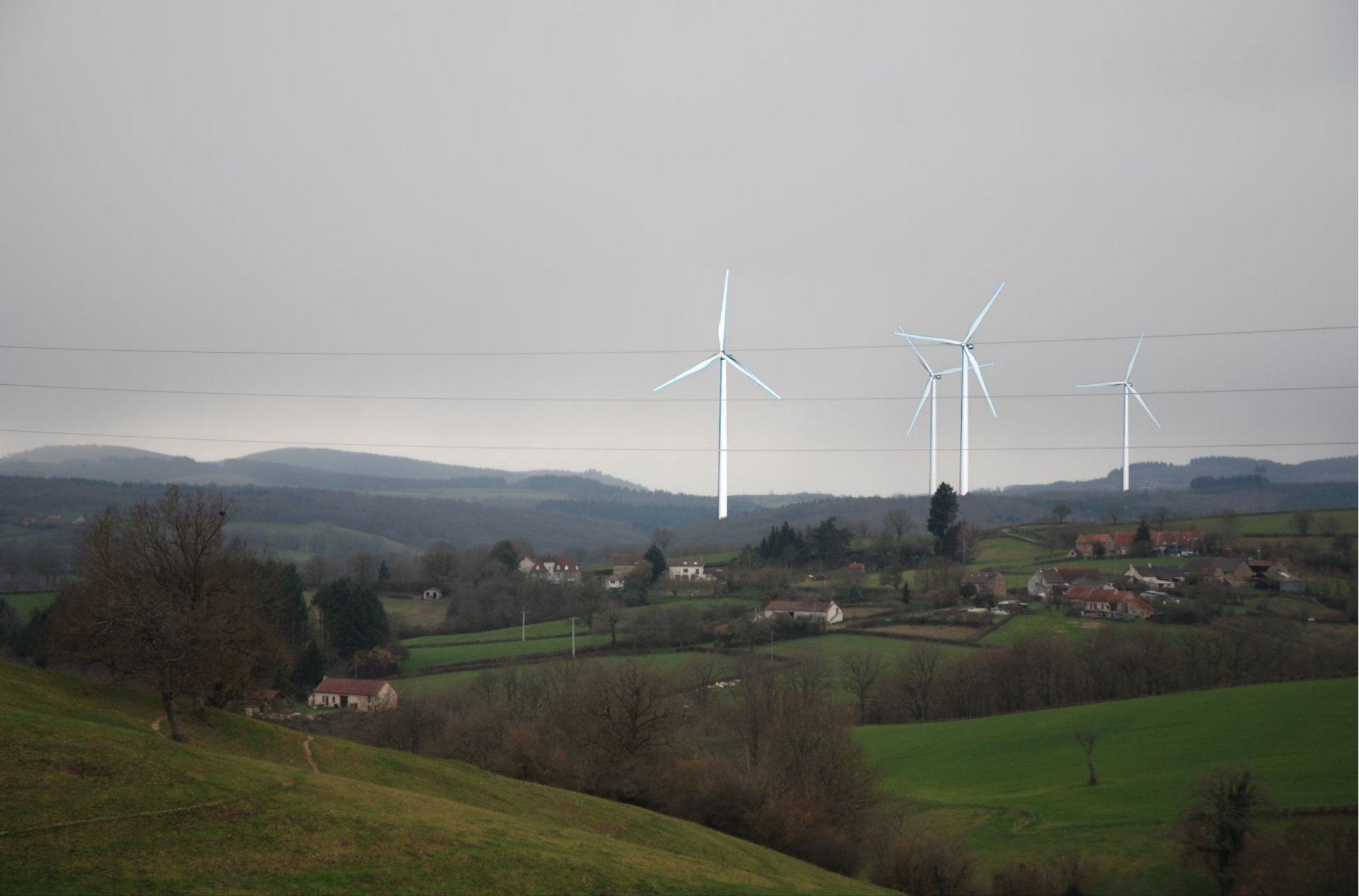
Saint-Bérain – Sur la D102 entre les Grandes Bruyères et les Charbonnières Courmarcou et les éoliennes du parc Nord ( 1ère éolienne à 2500 m)
